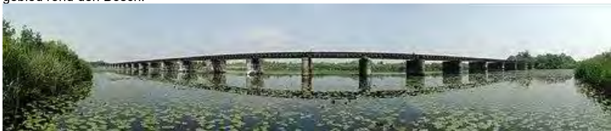
De spoorbrug midden door de Moerputten
