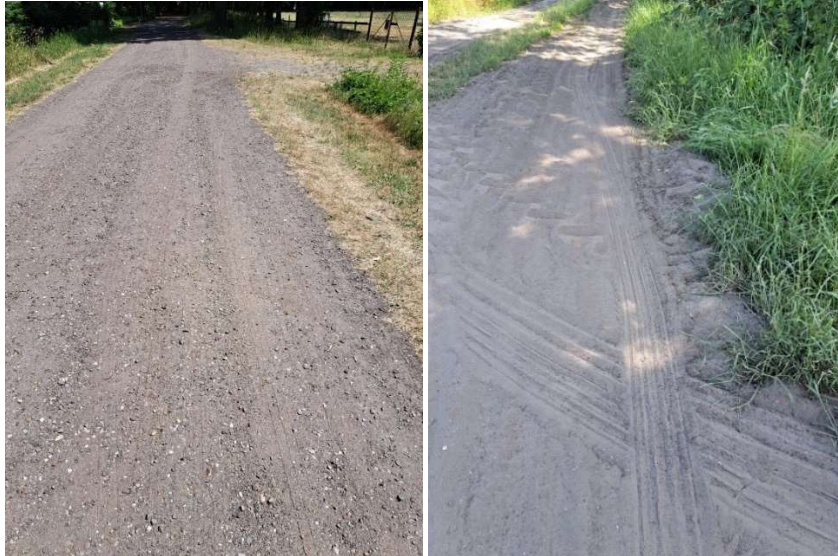
Figuur 3: Verschil tussen een half verhard pad (links) en onverhard pad (rechts).
