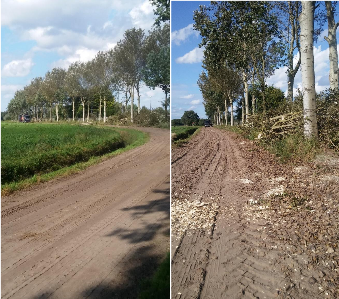
Kapwerkzaamheden 18 september '23: ook de ondergroei in de berm is grotendeels vernield
