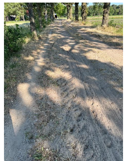
Figuur 17. Wandel- en fietsstrook langs de zandweg B3.
