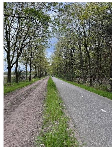
Figuur 19. Aparte verharde fietsstrook langs de Hanenberg (C9).
